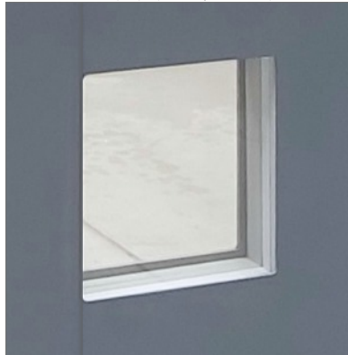
Wzór bez ramki przyszybowej od strony zewnętrznej
